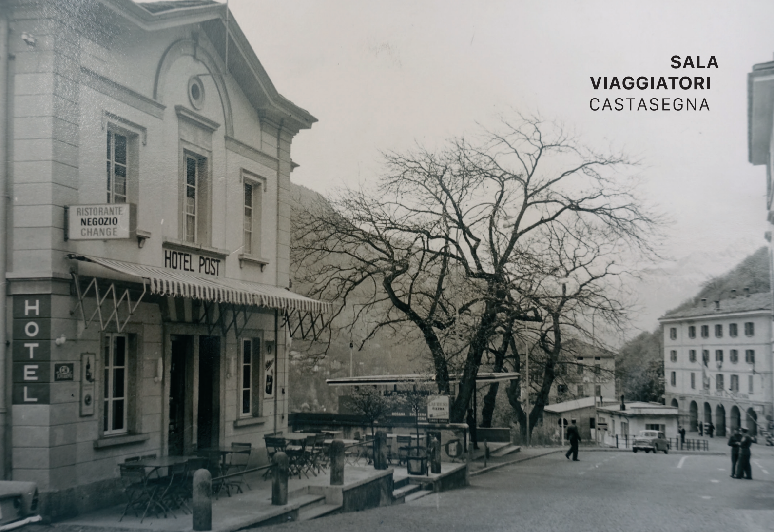
Hotel Post e l'edificio doganale presso il confine svizzero-italo, anni '60, Proprietà privata
